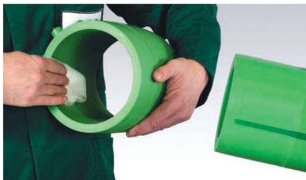
Figure 8 : Nettoyer l'intérieur du manchon électrique
