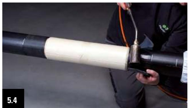
5.4 Détachez l'épais film de protection sur la face supérieure de bande thermo-adhésive et ce uniquement dans la zone de chevauchement au début de la bande et chauffez légèrement la face inférieure de la bande. Finalement poser la face chauffée et appuyer fortement sur la zone de chevauchement.
