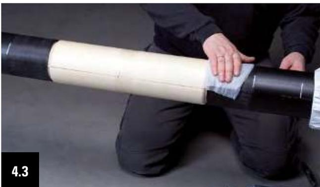
4.3 Nettoyer les deux extrémités poncées avec des languettes de nettoyage Tangit ou avec un linge propre, non gras et non pelucheux et de l'éthanol/ alcool (min 99.9%).
