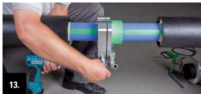
13. Après écoulement du temps de refroidissement, libérer l'étrier du tube en desserrant les vis de serrage.
