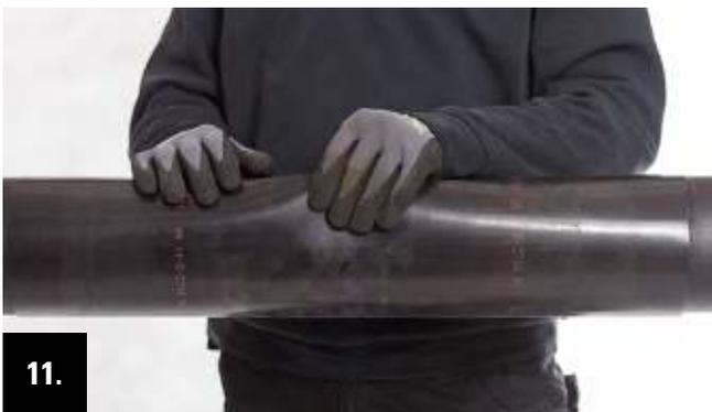
**11.** Poser de manière serrante le film rétractable sur les coquilles isolantes PUR et vérifier la présence d'une zone de chevauchement d'environ 10 cm.
