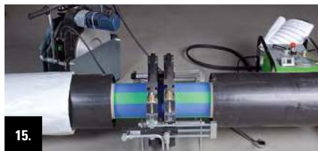
Rapprocher hydrauliquement et lentement les extrémités des tubes, les mettre en contact et exercer la pression définie.
