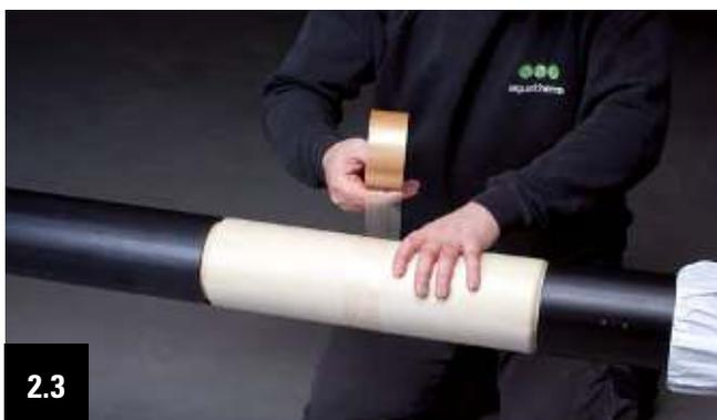
2.3 Pour fixer le maintien des coquilles isolantes PUR, on place une bande adhésive ordinaire au centre de l'ensemble.
