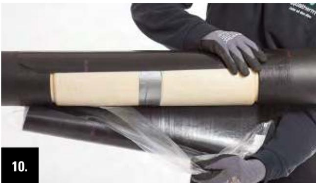
**10.** Dérouler de manière équilibrée le film rétractable sur la zone à recouvrir et simultanément retirer la feuille de protection de la face inférieure.
