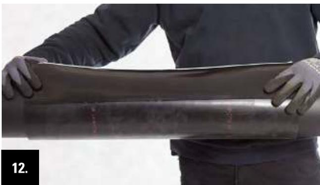
**12.** Placer les bandes de fermeture sur le recouvrement (min. 100 mm) du film rétractable et les presser fermement en veillant à une bonne adhérence.
