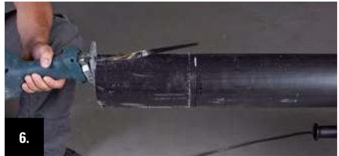
6. Couper le tube à l'aide d'une scie tigre ordinaire ou une scie queue de renard équipée d'une lame pour matière synthétique, le long de la ligne tracée.
