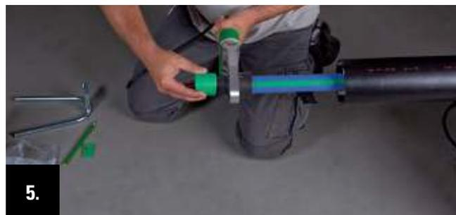
Après écoulement du temps de chauffe retirer le manchon et éloigner l'appareil de soudure.
