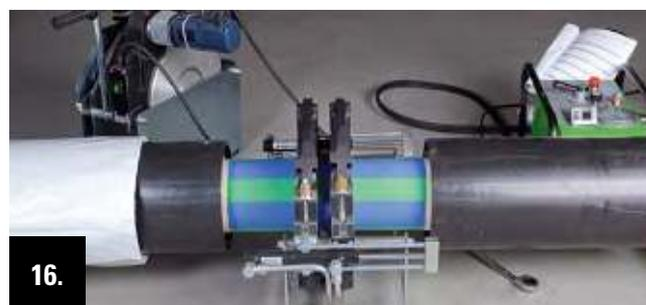
La pression réglée est maintenue jusqu'à écoulement du temps de refroidissement.
