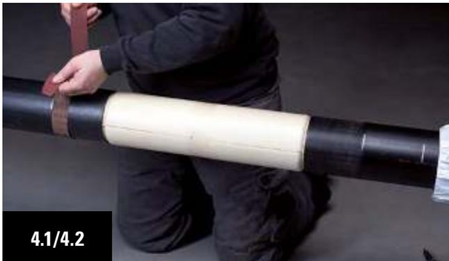
4.1 Travailler l'extrémité de la gaine jusqu'au repère tracé à l'aide d'une bande abrasive ou une toile émeri (grain 40 ou 60) sur tout le pourtour et toute la surface.
