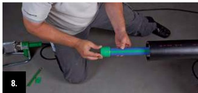
Orienter le manchon et le maintenir brièvement. Ne plus manipuler l'assemblage jusqu'à écoulement du temps de refroidissement.
