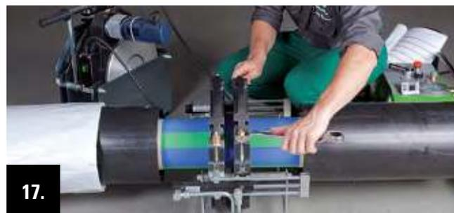
Après écoulement du temps de refroidissement, relâcher la pression. Finalement, les étriers sont ouverts et la machinerie écartée.
