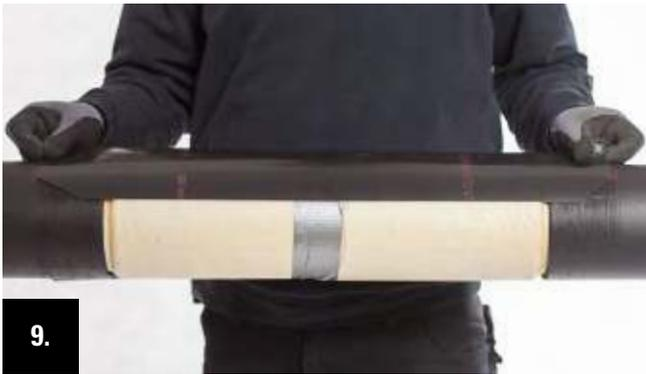
**9.** Vérifier avant la pose l'état impeccable de la manchette et la centrer sur la zone de recouvrement.
