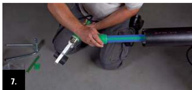
Le manchon est introduit et poussé sur le tube jusqu'au repère d'emboîtement.
