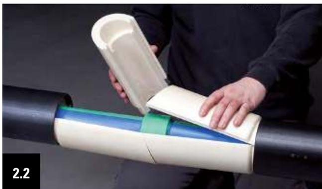
2.2 A présent, les deux autres coquilles isolantes PUR repérées 1 et 2 sont placées de manière identique . Le profil à rainures et languettes permet un assemblage sans aspérité et parfaitement adapté.
