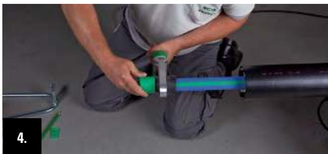
Pousser le manchon à souder sur la douille mâle et simultanément introduire la douille femelle sur l'extrémité du tube jusqu'au repère d'emboîtement tracé.
