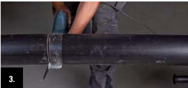
3. Couper le tube à l'aide d'une scie tigre ordinaire ou une scie queue de renard équipée d'une lame pour matière synthétique, le long de la ligne tracée.
