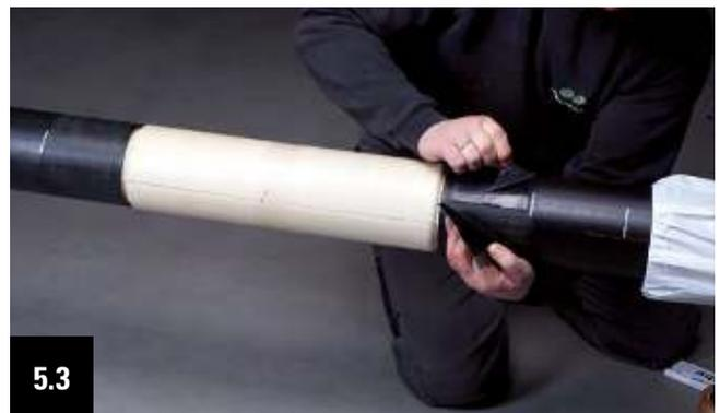
5.3 Positionner la bande fusible à environ 20mm du marquage du centre de l'axe à un angle de 90° par rapport à l'axe du tube et l'enrouler fermement sur le tube gaine.
