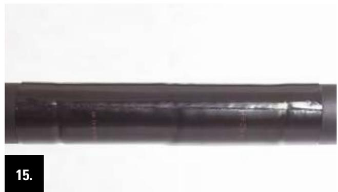
**15.** Le processus de rétraction est achevé lorsque le film enserre complétement et sans poche d'air , les coquilles PUR et le tube gaine.
