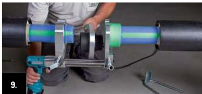
9. Après écoulement du temps de chauffe, libérer, par recul du rapprocheur, l'appareil de soudure.
