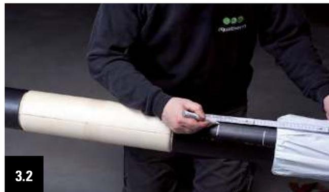
3.2 Reculer la manchette au- delà du repère tracé tel que décrit au point 3.1. Mesurer la distance entre ce marquage et le front du tube- gaine et tracer un nouveau repère qui indiquera le centre de l'axe.
