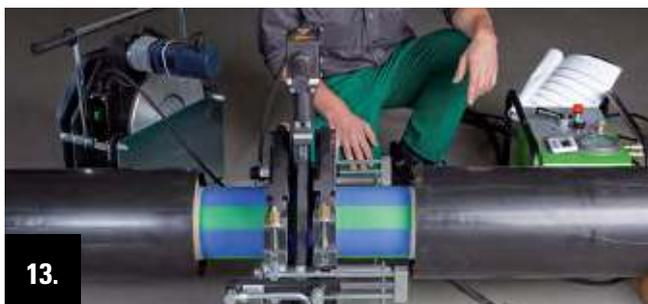
Réduire la pression dès que le bourrelet a atteint la hauteur voulue. C'est après cette opération que débute le temps de chauffe. Ce temps sert à placer les extrémités des tubes sous la température nécessaire à l'assemblage.
