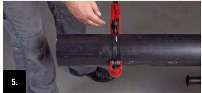
5. Éliminer à l'aide d'un coupe tube la gaine extérieure jusqu'à l'isolant en PUR.
