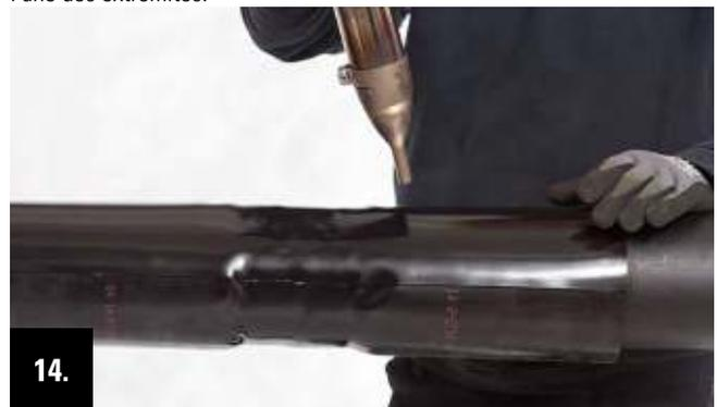
**14.** Donner à l'appareil de chauffe (décapeur thermique ou brûleur propane) un mouvement spiralé et circonférentiel continu ainsi que de gauche à droite.
