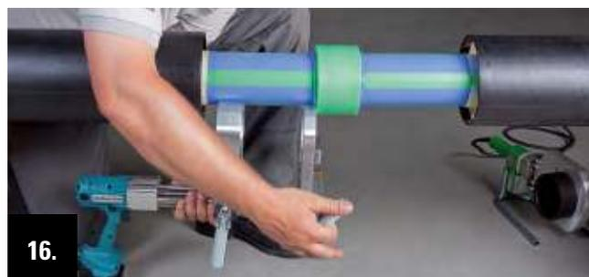
16. Les étriers complètement ouverts, retirer par le bas ou le côté le rapprocheur de l'assemblage réalisé.
