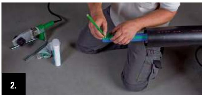
Repérer et tracer la profondeur d'emboîtement au moyen d'un crayon graphite.
