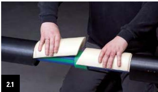
2.1 Chaque coquille isolante PUR repérée sous le chiffre 1 et 2 est introduite dans les cavités se trouvant au front des tubes- gaines et finalement assemblées en parallèle à l'axe du tube transporteur et enfin tournée au bas de la conduite.
