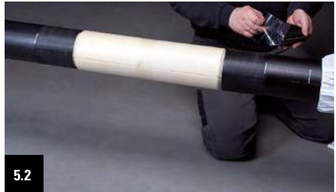
5.2 Retirer la fine feuille de protection se trouvant sur la face inférieure de la bande fusible.
