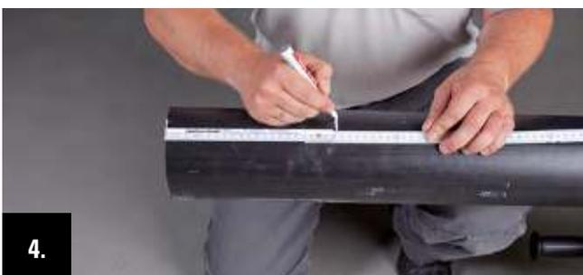
4. Éliminer sur l'extrémité du tube l'isolant et sa gaine sur 22.5cm.
