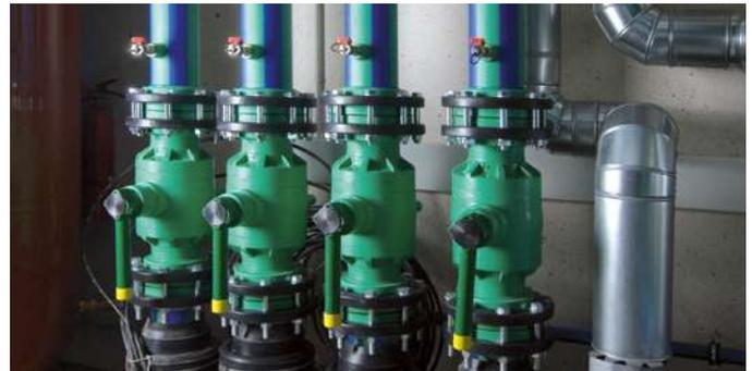
Les colonnes montantes et la distribution d'étages d'installations de chauffage doivent être conçues et montées avec le blue pipe composite fibré aquatherm.
