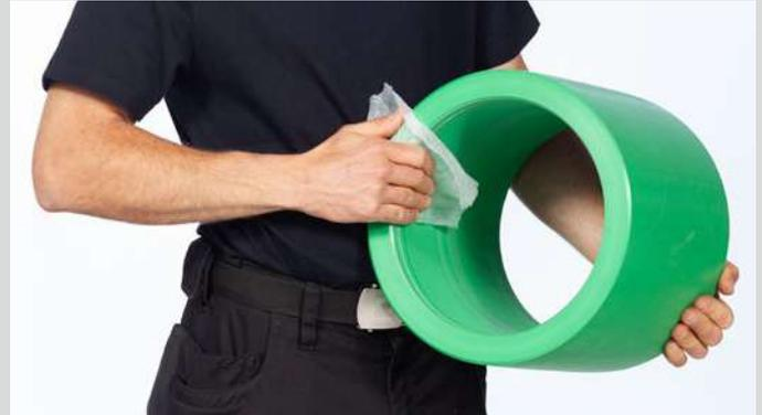
Nettoyer l'intérieur du manchon électrique avec un chiffon non pelucheux ou du papier. **Directement avant la soudure**, éliminer le cas échéant une nouvelle fois toute trace d'humidité.
