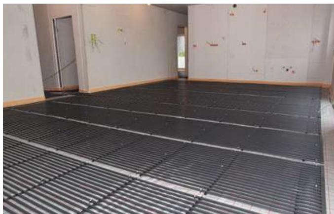
2. aquatherm black system comme système de chauffage de surface sur isolation réalisée sur le site.
