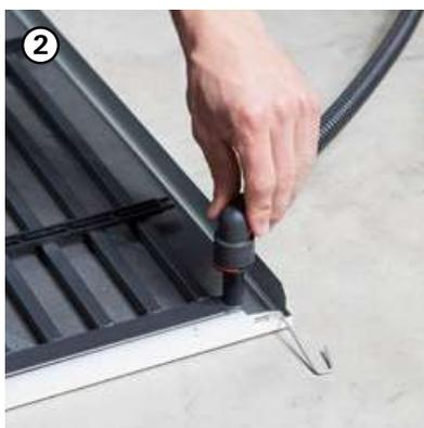
**Remarque :** pour assembler les deux éléments, il faut contre soutenir d'une main. À défaut de contre appuyer d'une main, il y a risque de déformation du panneau de plafond métallique !
