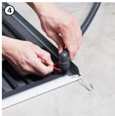
5. Saisir l'adaptateur en pleine main tout en provoquant le retrait de la bague de maintien avec le pouce et l'index. Ce faisant, la bague de serrage interne s'ouvre.
