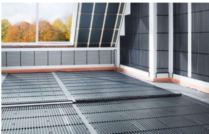
1. Chauffage mural et au sol combinés en un circuit de chauffage
